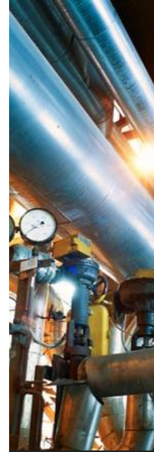
Abwärme wird geprüft
