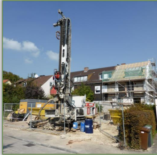
Erdsonden-Bohrung
