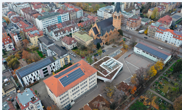
Die Photovoltaik-Anlage auf den Dächern der Martin-Luther-Schule kann rechnerisch 80 Drei-Personen-Haushalten mit Solarstrom versorgen.
