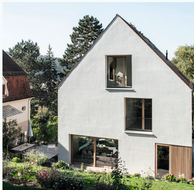
Saniertes Gebäude im Stuttgarter Süden.
