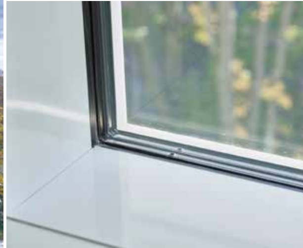
Fenster mit Dreischeibenverglasung und hochwärmedämmendem Fensterrahmen
