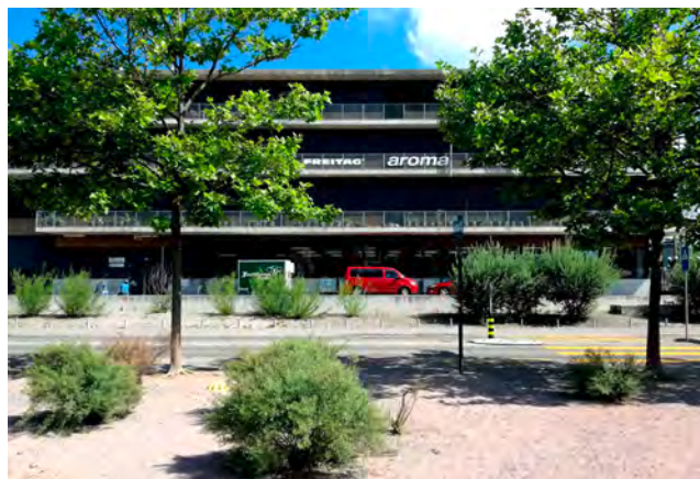
Gewerbehaus NOERD, Binzmühlestrasse, Zürich-Oerlikon
