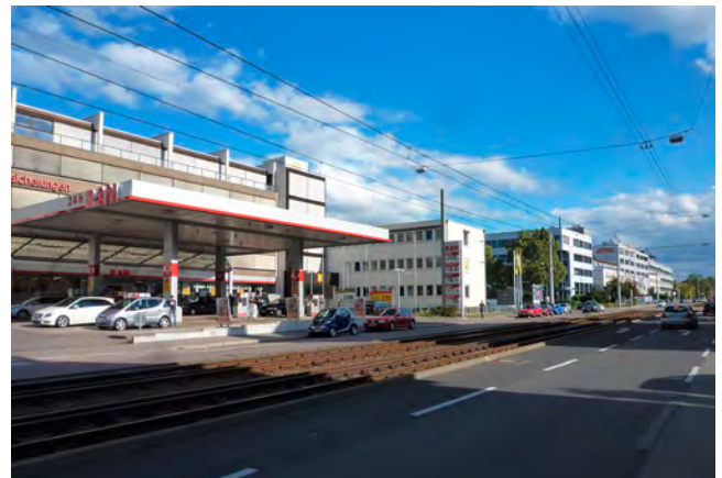
Gewerbequartier Wangen Nord, Stuttgart-Wangen
