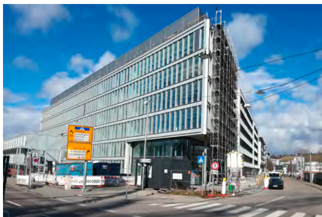
BOSCH, Gewerbequartier Feuerbach-Ost, Borsigstraße, Stuttgart-Feuerbach
