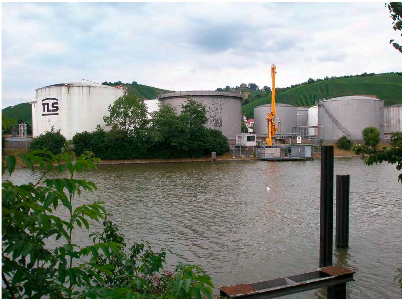
Tanklager am Ölhafen, Hafen Stuttgart, Stuttgart-Untertürkheim
