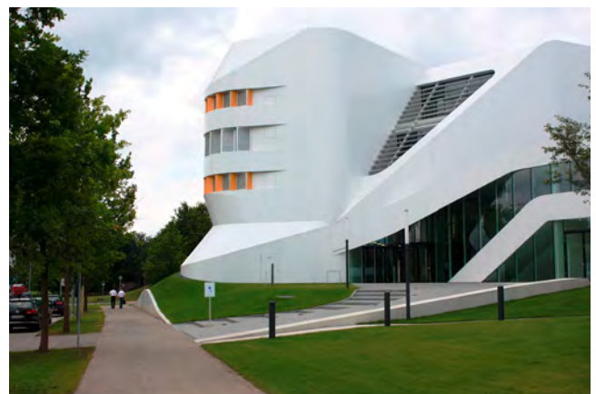
Oben: Hochschule der Medien, Campus Vaihingen, Stuttgart-Vaihingen Unten: Fraunhofer IAO, Campus Vaihingen, Stuttgart-Vaihingen
