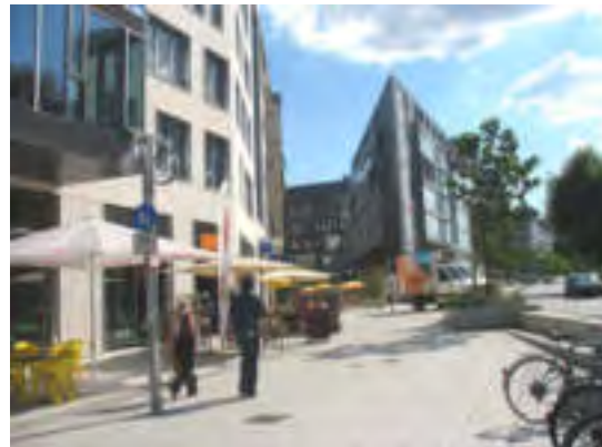
Foto 29: neu gestaltete Fußwegbereiche Theodor-Heuss-Straße
