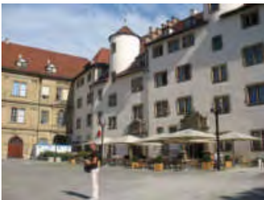
Foto 24: Alte Kanzlei auf Schillerplatz
