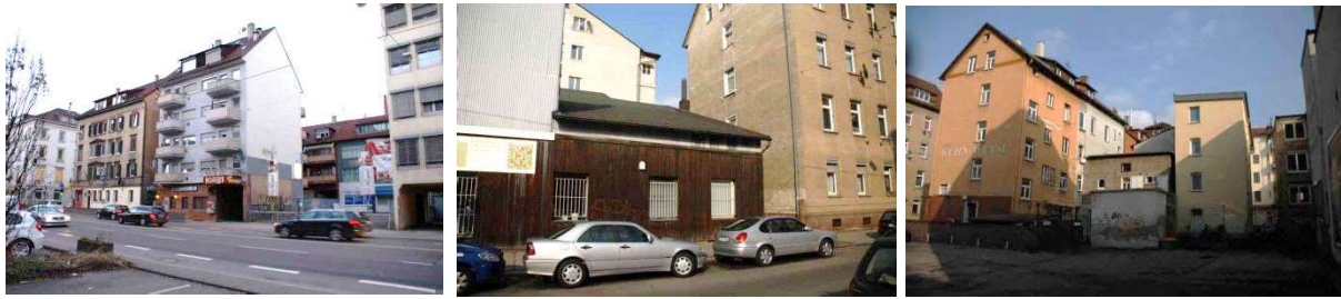
Gestörte, zum Teil nicht ausgebildete Blockränder zwischen Cottastraße und Fangelsbachstraße
