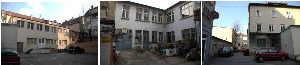
Fehl- und Unternutzungen von gewerblich genutzten Gebäuden in den Blockinnenbereichen
