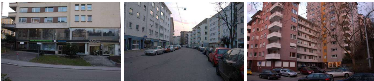
Modernisierungsbedarf und Defizite im öffentlichen Raum, u.a. Bereich Gerda-Taro-Platz/Alexanderstr.
