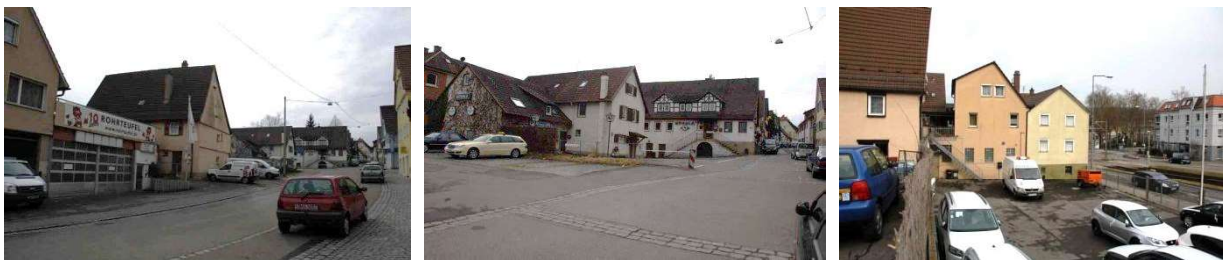
Fehl- und Unternutzungen (z.T. Leerstand) im Bereich Eltinger Straße und Kauffmannstraße
