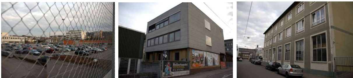
Untergenutzte Gewerbeflächen, Modernisierungsbedürftige Bausubstanz und Leerstand
