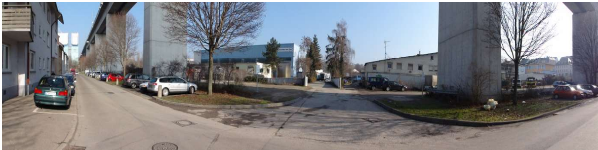
Prägung der Bestandssituation durch das Neckarviadukt
