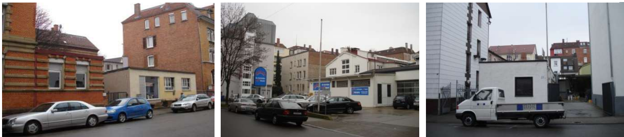
Defizite in den Blockinnenräumen im Quartier Seelberg
