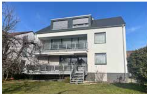
Wohnhaus in Stuttgart-Möhringen vor und nach der energetischen Sanierung. Der Endenergiebedarf konnte um 47 Prozent reduziert werden.
