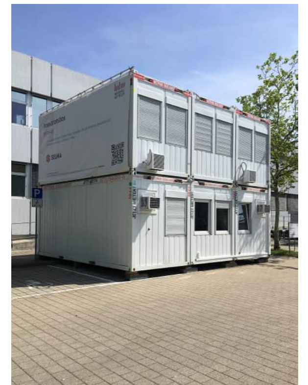
Hochschule der Medien: GENERATOR (temporäre Ergänzung des Raumangebots)
